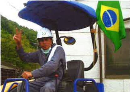
石巻市でがれきの撤去作業をするブラジル人
