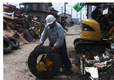
東日本大震災の直後から、自社の重機を持ち込んで瓦礫撤去を行なった
