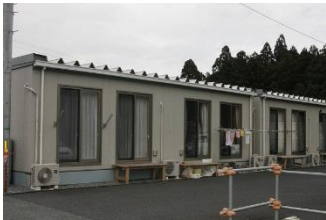
劣悪な住環境の仮設住宅
